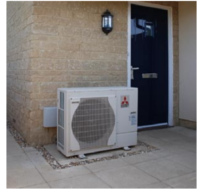
Fig. 24 Air source heat pump fan unit
